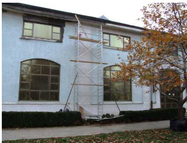
Момент от ремонта на Източната фасада.
