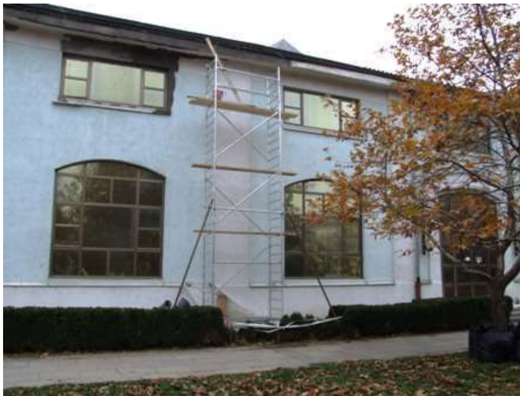
Момент от ремонта на Източната фасада.
